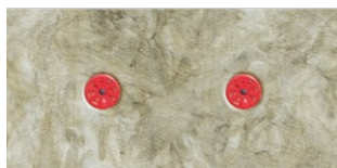
Фрагмент плиты на втором слое утепления
